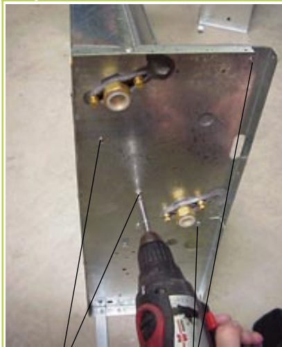
Schrauben der Registerhalterung Schrauben der Kondensatwanne
