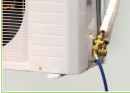
16 Manometerschlauch befestigen
