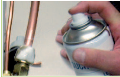
17 Besprühen der Verbindungsstelle
