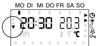
Anzeige bei geschaltetem Ausgang „Kühlen“
