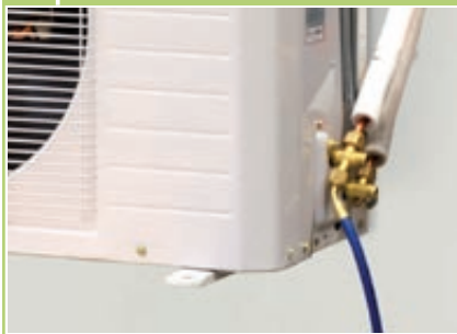
16 Manometerschlauch befestigen
