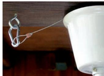
Befestigen Sie das Sicherheits-Drahtseil mit der Öse oder Schraube ca. 10 cm außerhalb der oberen Blende an der Decke.
