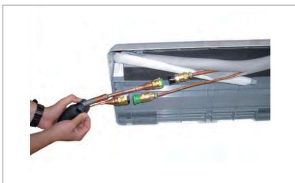
Fig. 32: Installation au niveau de l'unité intérieure
