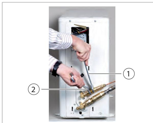
Fig. 33: Serrage des raccords vissés
