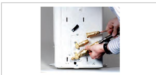
Fig. 31: Position des raccords rapides
