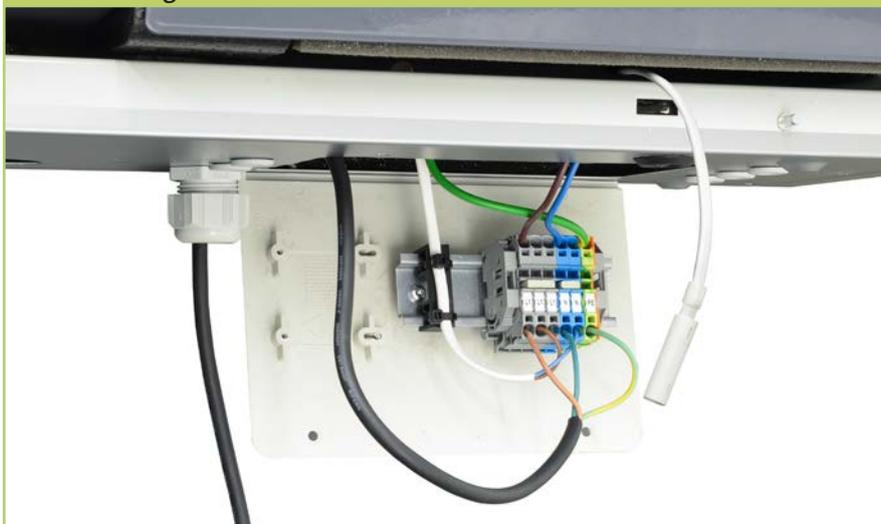
7. Refermer et fixer le clapet de raccordement.
