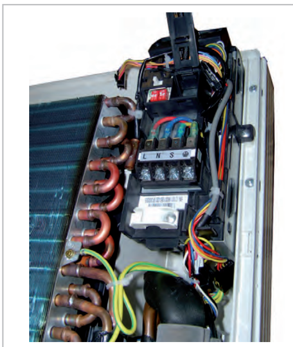
Fig. 15: Branchement de l'appareil intérieur
