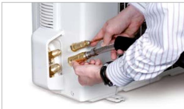
Einfache Montage durch separat erhältliches Anschluss-Set
