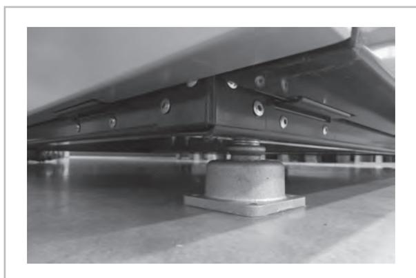
*Fig. 20: Amortisseur de vibrations monté*
