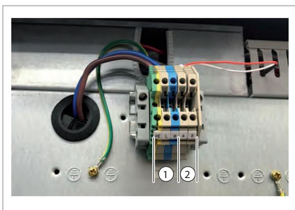
Fig. 8: Bornes de raccordement du module externe WKF/WKF-compact 80/100/130
