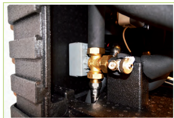
Abb. 16: Anschluss Vorlauf am Umschaltventil
