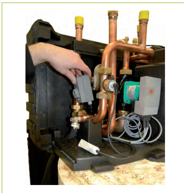
Abb. 18: Stellmotor installieren
