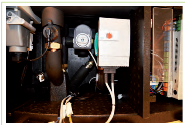
Abb. 17: Anschluss Wilo-Pumpe
