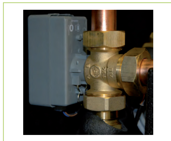
Abb. 15: Anschluss Vorlauf am Umschaltventil
