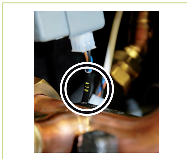
Abb. 19: Stellmotor verbinden
